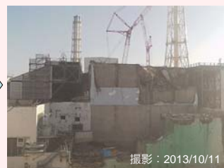
大型ガレキ撤去後
