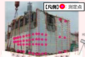
傾きの確認(外壁面の測定)
