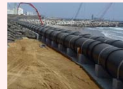
配水管設置状況②
