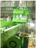
燃料取り出し状況
