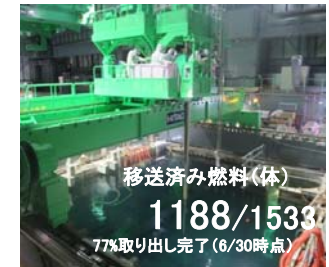
※クレーン点検のため7/1～9月上旬まで作業中断（燃料取り出し状況）
