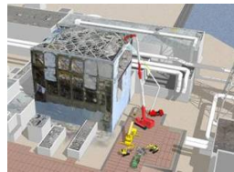
原子炉建屋上部のガレキ撤去
