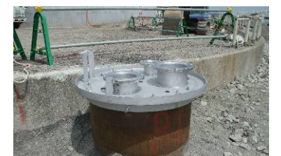
地下水ドレン汲み上げ用井戸設置状況（1号取水口前）
