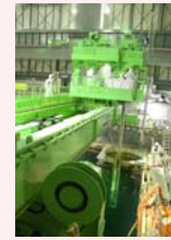
燃料取り出し状況
