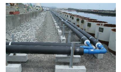
地下水ドレン配管設置状況
