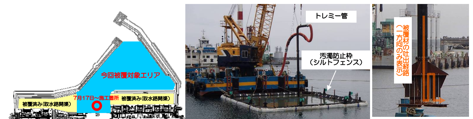
図9：港湾内海底土被覆工事の作業状況
