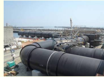
<配水管設置状況>
