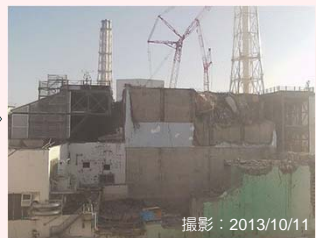
大型ガレキ撤去後
