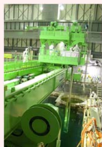
燃料取り出し状況
