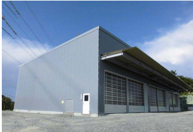
図8：車両整備場 外観
