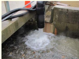
<地下水バイパス 排水状況>
