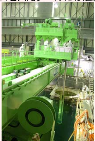
燃料取り出し状況
