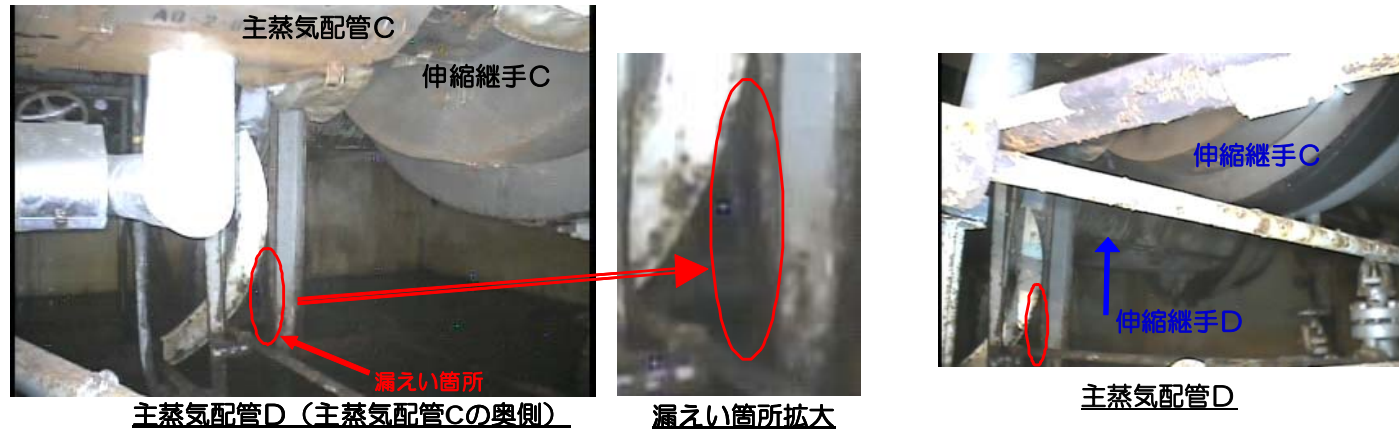
図5：3号機主蒸気隔離弁室内調査状況
