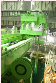
燃料取り出し状況
