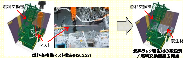
<3号機 使用済燃料プール内ガレキ撤去の状況>
