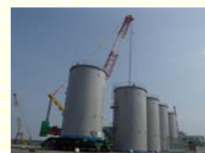
<陸揚げされたタンク>
