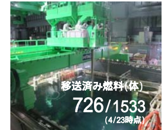
(燃料取り出し状況)
