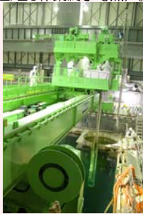
燃料取り出し状況
