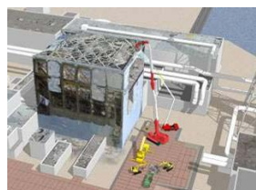
原子炉建屋上部のガレキ撤去
