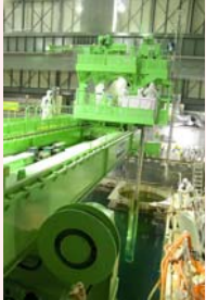
燃料取り出し状況
