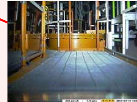
南東マンホール
