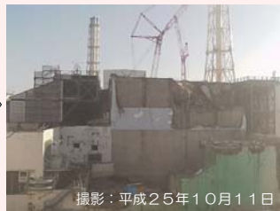
撮影:平成25年10月11日 大型ガレキ撤去後
