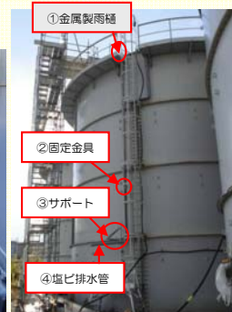
<雨樋設置状況>
