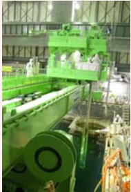
燃料取り出し状況
