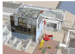
原子炉建屋上部のガレキ撤去
