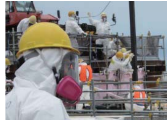
全面マスク着用による作業例
