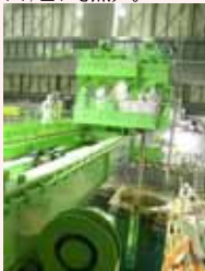
燃料取り出し状況
