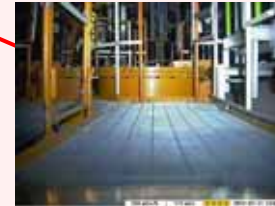
南東マンホール
