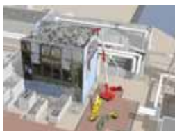
原子炉建屋上部のガレキ撤去
