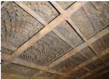
例：チューブ燃焼灰付着状況
