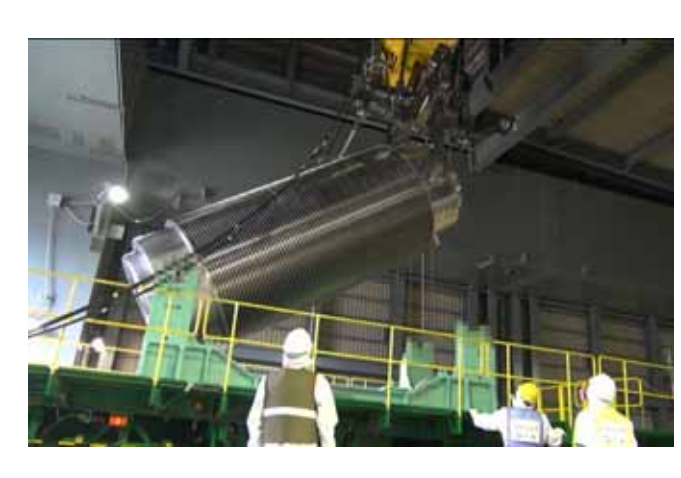
構内用輸送容器のトレーラへの積み込み（11/21）
