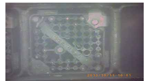
ガレキ吸引作業後
