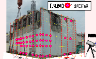
傾きの確認(外表面の測定)
