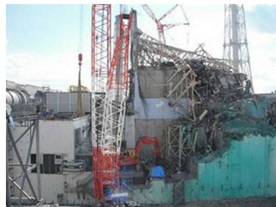
大型がれき撤去前
