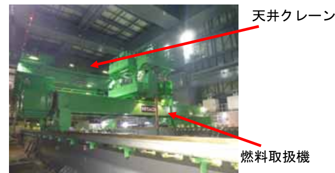
図5：4号機 天井クレーン、燃料取扱機の設置
