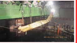
使用済燃料プール内大型ガレキ撤去作業
