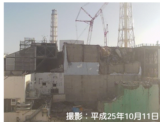
大型がれき撤去後
