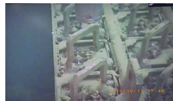
ガレキ吸引作業前
