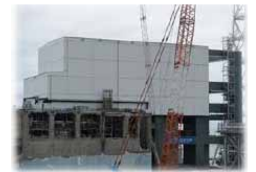
図6：燃料取り出し用カバーが設置された4号機
