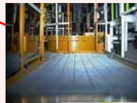
南東マンホール
