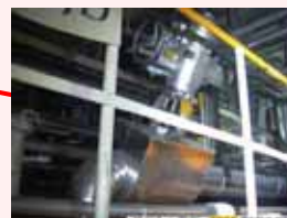
格納容器側状況
