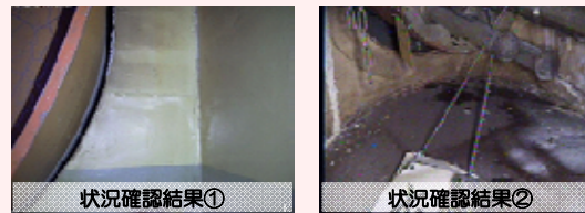
1号機パーソナルエアロック室の様子
