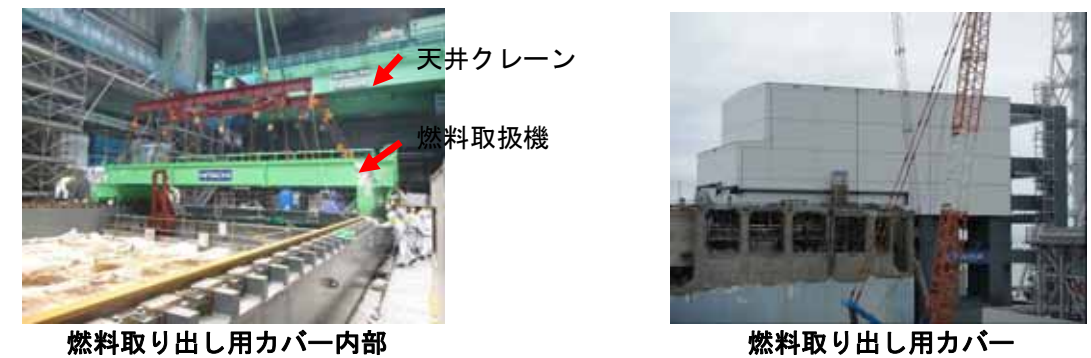
図5：4号機燃料取り出し用カバー設置状況
