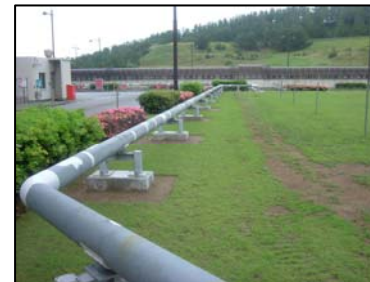
消火配管の地上化
