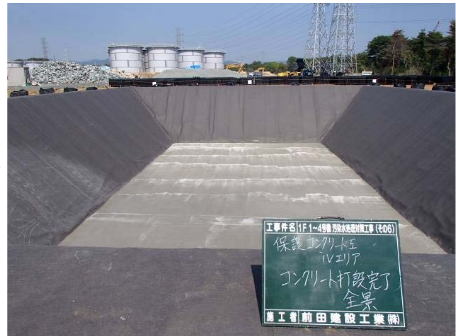
【保護コンクリート打設完了】
