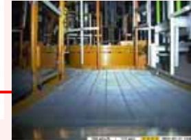
南東マンホール ロボットによるトラス室調査 (2012/7/11)
