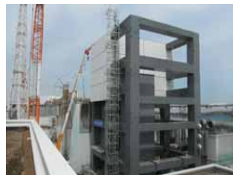
鉄骨建方実施状況(4/23撮影)
