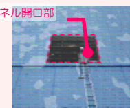
閉止パネル設置前
