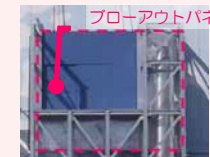
閉止パネル設置完了後
