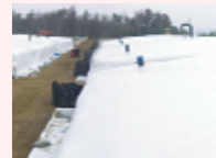
伐採木一時保管槽の設置状況(4/2)
