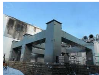
第1節部分鉄骨建方終了 (1/14)
