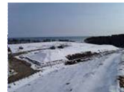
1 槽目の状況 (1/16撮影)
