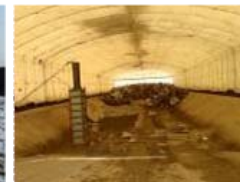
2 槽目の状況 (1/16撮影)
