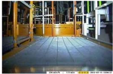
ロボットによるトラス室調査(H24/7/11)
