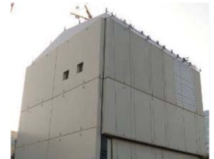
1号機原子炉建屋カバー設置
