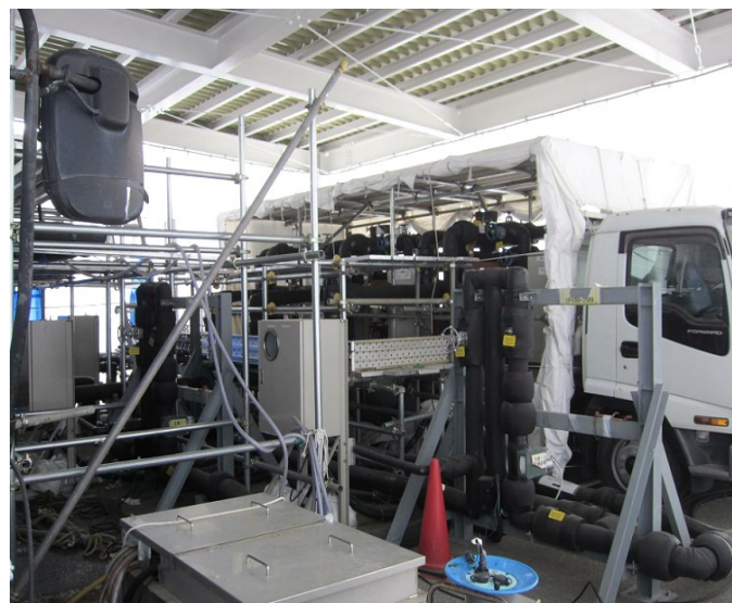
< 非常用高台炉注水ポンプ >
