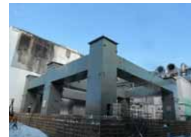
第1節部分鉄骨建方終了（1/14）
