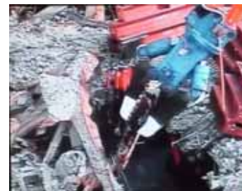
吊り上げ時の様子
