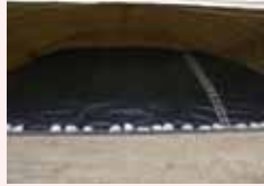
1槽目の様子（12/13） 遮水シート設置中
