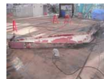
撤去後の様子
