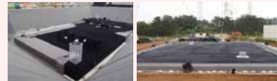
地下貯水槽設置状況
