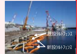
シルトフェンス交換の様子
