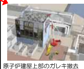
原子炉建屋上部のガレキ撤去
