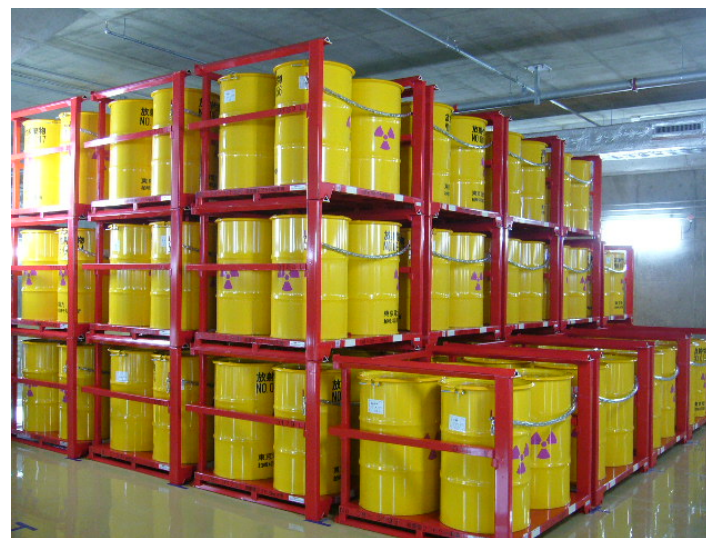
転倒防止架台(ネステナー)による保管
