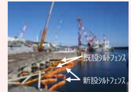
シルトフェンス交換の様子
