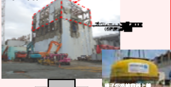
原子炉格納容器上蓋吊り下ろし(2012/8/10)
