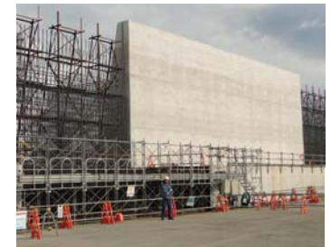
③3号機海側(8月28日撮影)
