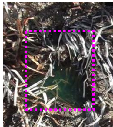
瓦礫撤去作業前（H23.11.12）
