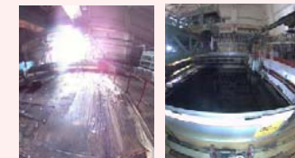
2号機5階の様子
