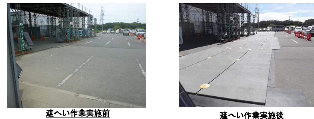
図3：通勤バス待機場所の遮へい作業の様子
