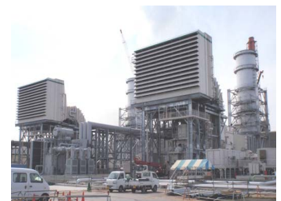
鹿島火力発電所 (GT3台)
