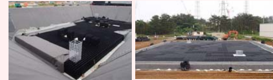
地下貯水槽設置状況
