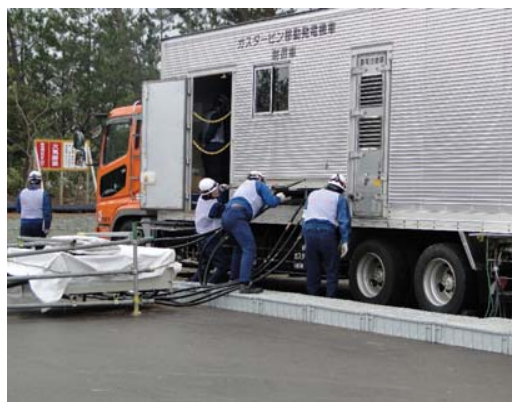
GTGによる電源供給訓練風景
