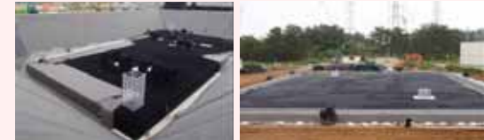
地下貯水槽設置状況
