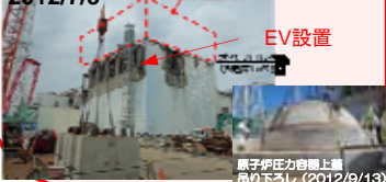
原子炉建屋上部のガレキ撤去
