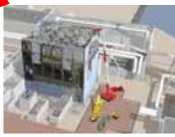
原子炉建屋上部のガレキ撤去
