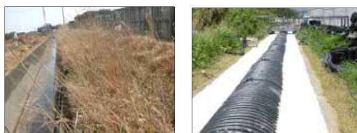
図2：排水路の暗渠化の様子
