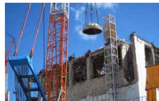
図3：大型機器撤去(原子炉压力容器上蓋)の様子(9/13)
