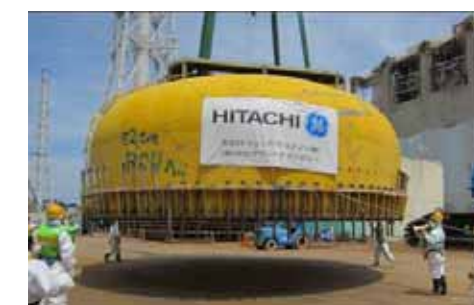
吊り降ろし作業
