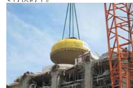
オペフロ上部での吊り上げ作業開始
