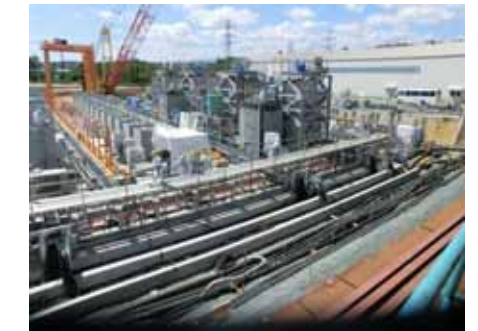
図2：多核種除去設備機器設置の様子（8/19）
