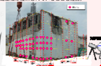
傾きの確認(外壁面の測定)
