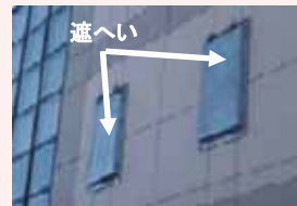
鉛材による窓部遮へい状況
