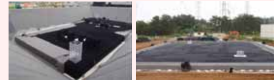
地下貯水槽設置状況
