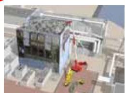
原子炉建屋上部のガレキ撤去
