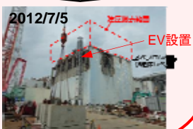
原子炉建屋上部のガレキ撤去
