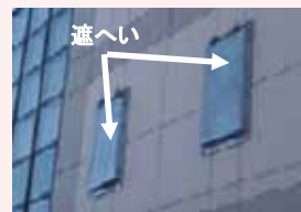
鉛材による窓部遮へい状況
