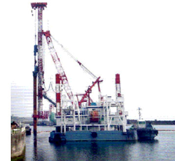
図2：遮水壁先行掘削作業状況
