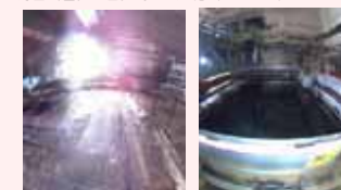
2号機5階の様子
