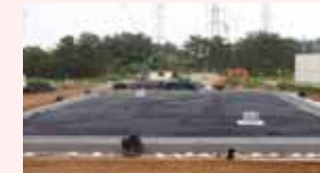
地下貯水槽設置状況
