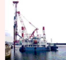
遮水壁先行削孔作業状況
