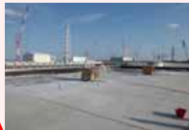
屋上コンクリート撤去状況
