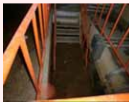
3号機階段室(北西)
