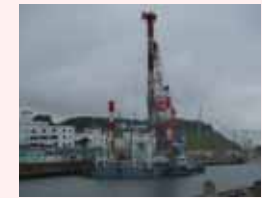
遮水壁先行削削準備作業状況
