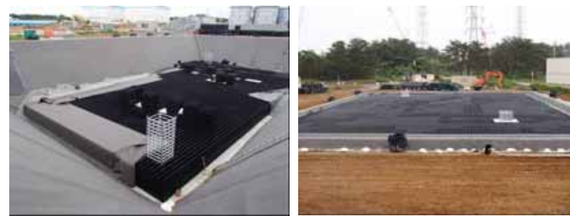
図2：地下貯水槽設置状況
