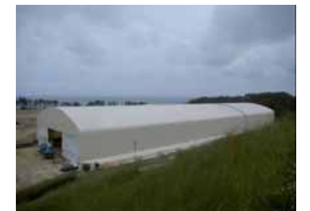
図5：覆土式一時保管施設準備工事完了（1層目：H24.6.13撮影）
