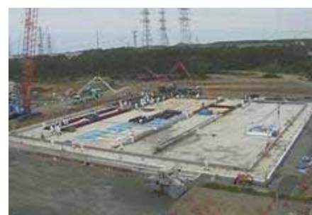
図1：多核種除去設備基礎施工状況
