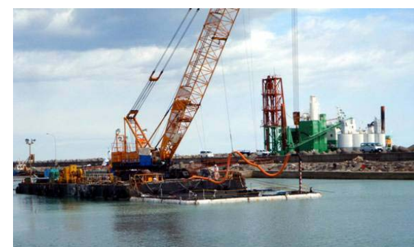
図3：1～4号機取水路前面エリアでの海底土被覆本格施工の様子
