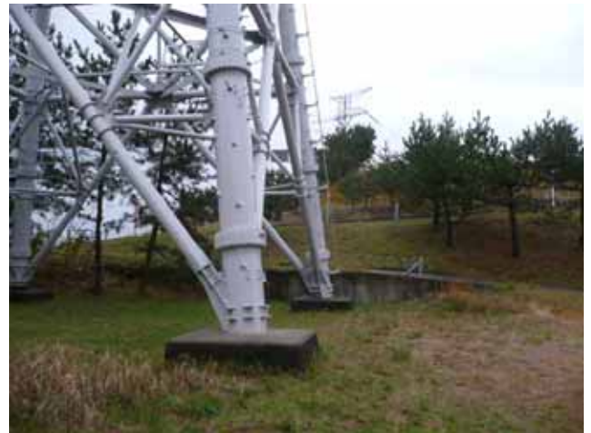
盛土高：約 1.2 m、鉄塔脚離隔：約 6 m
