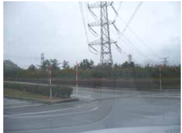
盛土高：約 1.5 m、鉄塔脚離隔：約 4.0 m
