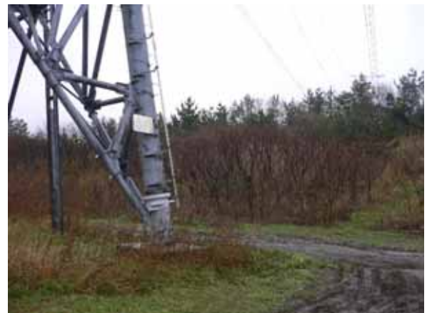
盛土高：約 8 m、鉄塔脚離隔：約 1.4 m
