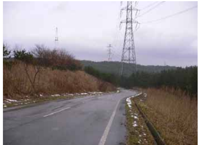
盛土高：約 1.7 m、鉄塔脚離隔：約 0 m
