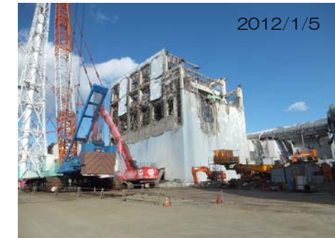
図5. 4号機原子炉建屋上部瓦礫撤去の状況
