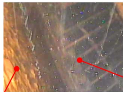
原子炉格納容器内壁
