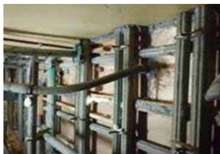
グラウト注入状況(7/30撮影)
