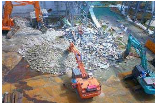
4号機周り支障物解体
