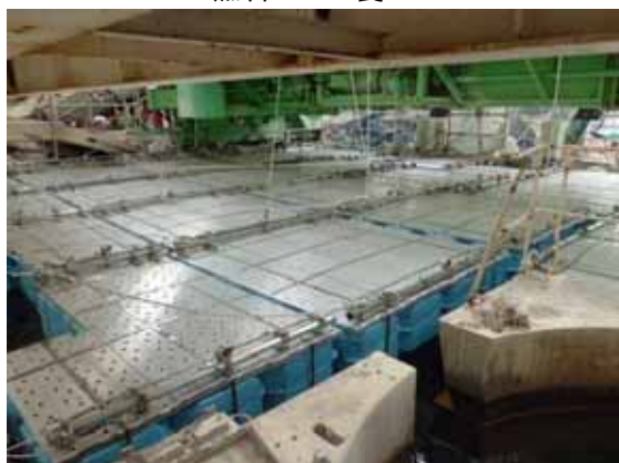
燃料プール養生
