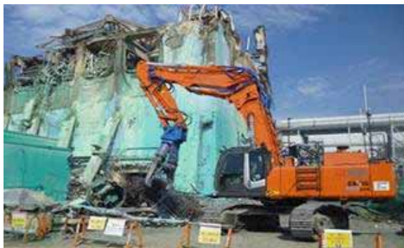
3号機原子炉建屋周り落下瓦礫の撤去
