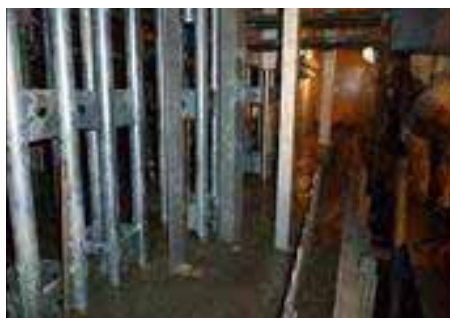
コンクリート打設状況(7/21撮影)
