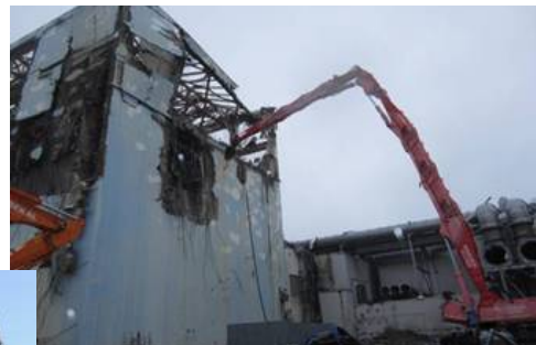
4号機瓦礫撤去作業
