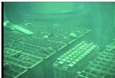
4号機使用済燃料プールの状況
