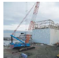
工事開始（6月28日）
