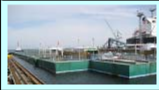
保管: タンク、マガフロード 処理: ゼオライトによる除染
