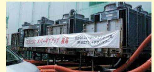
4号機の使用済燃料プールの冷却設備
