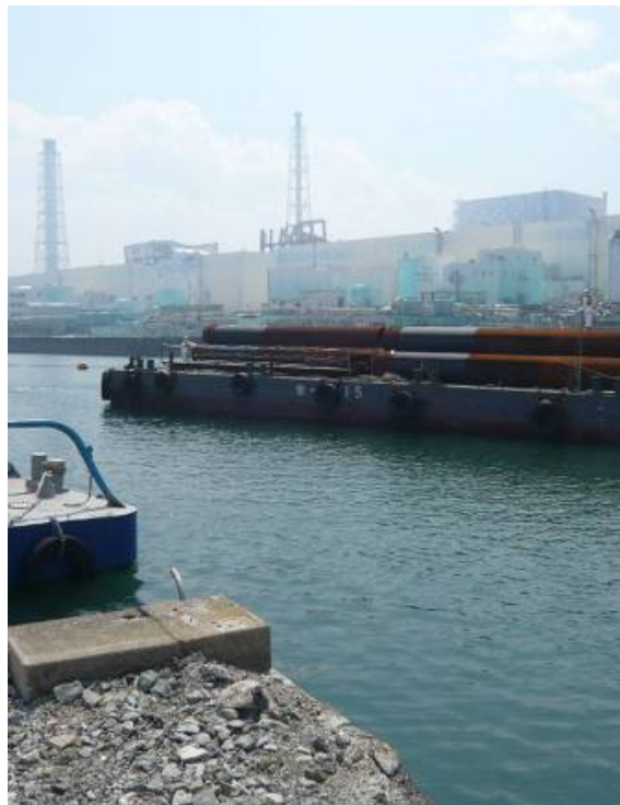
鋼管矢板搬入
