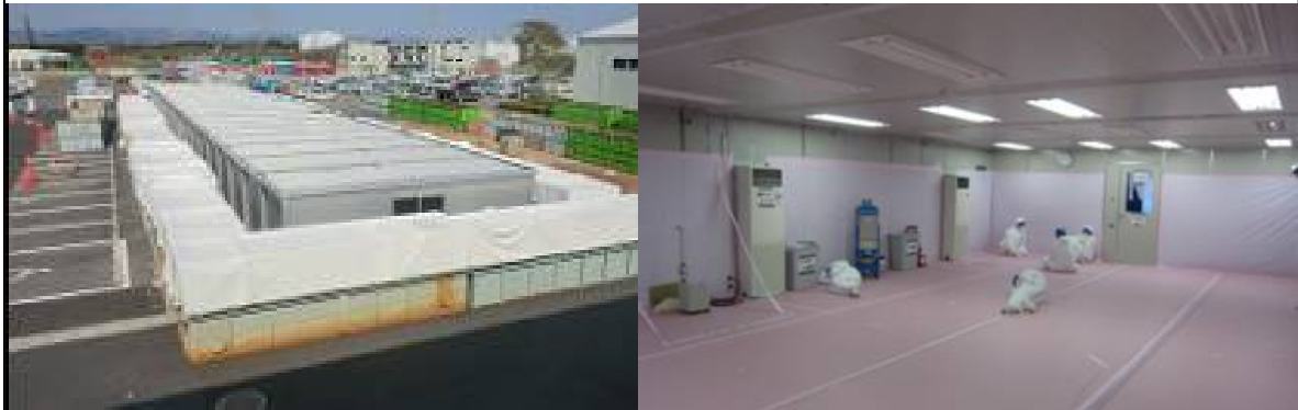
現場休憩施設外観(左)と内観(右)
