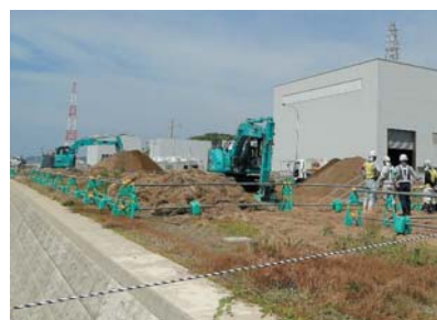
設置予定箇所の調査（6月22日）
