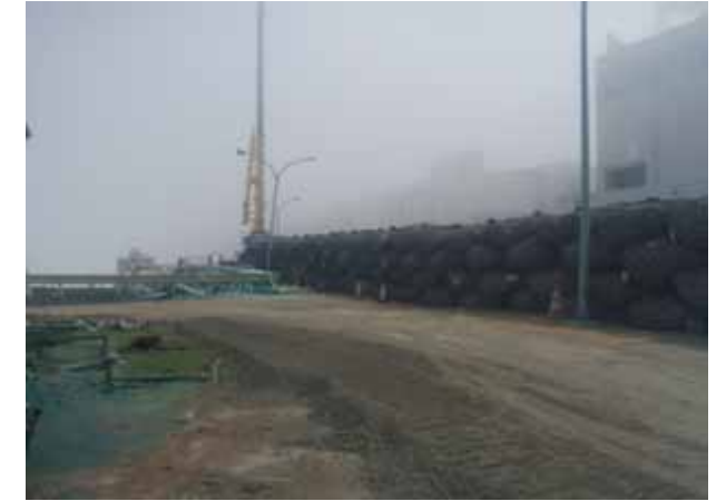
仮設防潮堤設置状況(1)
