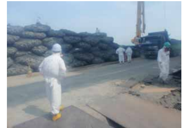
仮設防潮堤設置状況(2)
