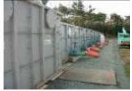
処理水受タンク
