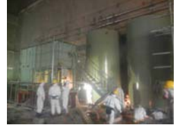
除染装置据付
