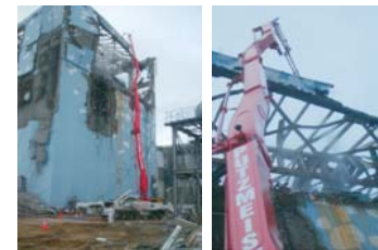
注水装置による注水
