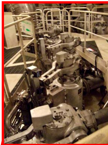
主蒸気逃し安全弁(18台)
