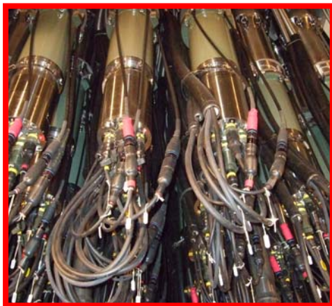
制御棒駆動機構(205台)
