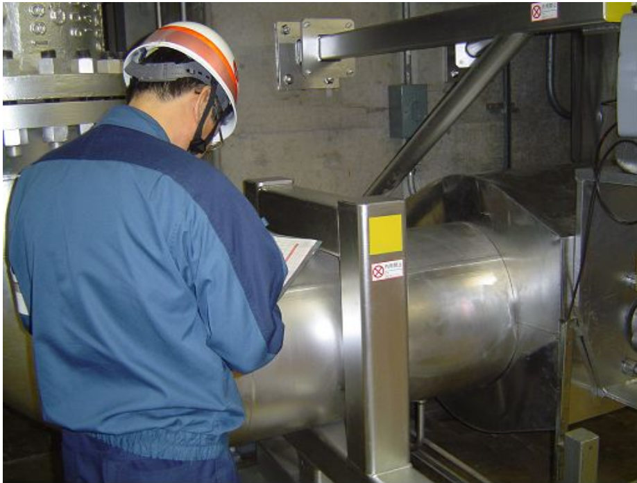
耐震補強した設備の確認
