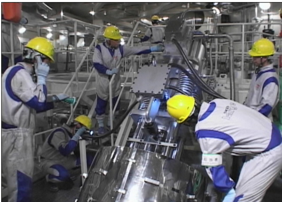
蒸気が通る箇所（主蒸気隔離弁） の点検を実施
