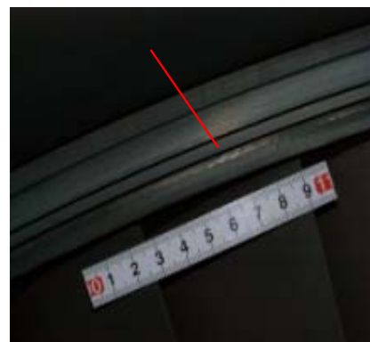
第9段発電機側ダイヤフラム
