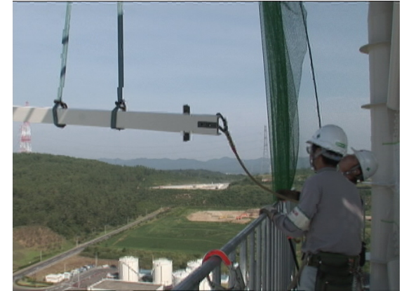
制震装置の設置
