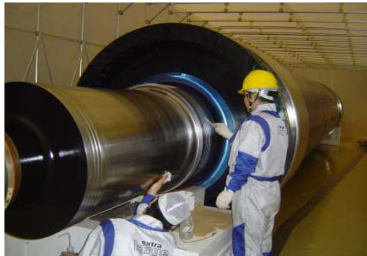
発電機ローターの点検(5号機)
