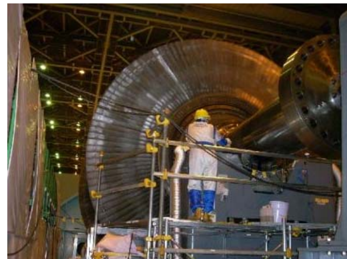
低圧タービンロータバランス調整
