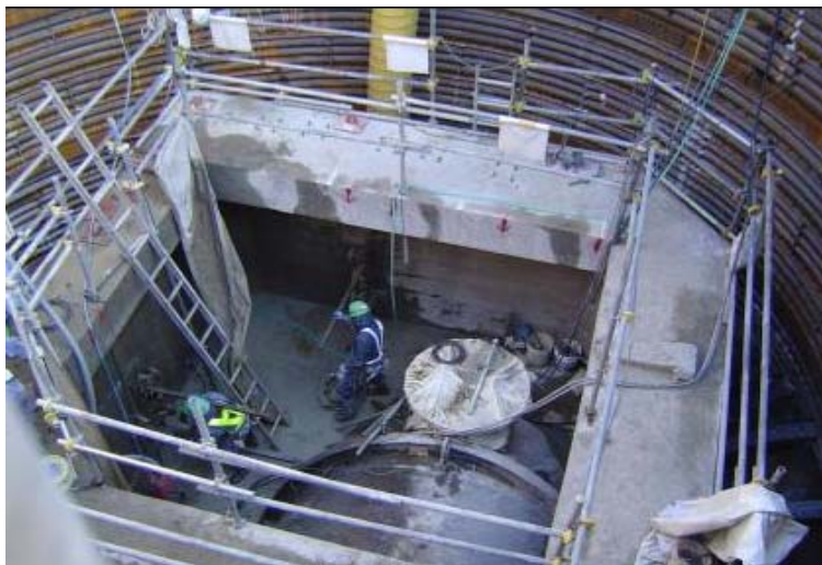
循環水配管点検(1号機)
