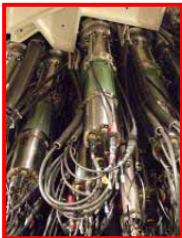
制御棒駆動機構(205台)
