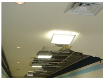
中央制御室通路前天井の損傷 (4号機)
