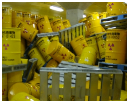
ドラム缶の転倒 (固体廃棄物貯蔵庫)
