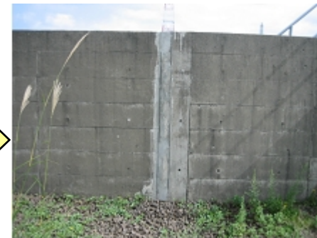
重油タンク防油堤での目地の開き
