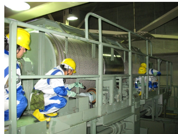
2号機 天井クレーンの点検
