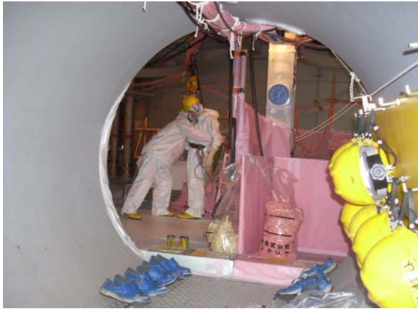
7号機 圧力抑制室の点検
