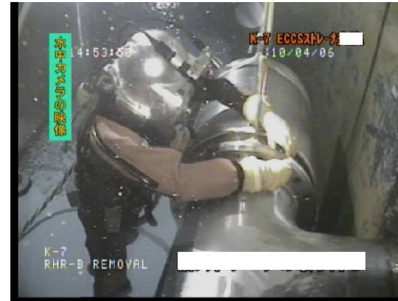
7号機 圧力抑制室の点検(潜水作業)
