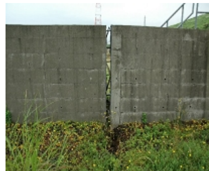
重油タンク防油堤での目地の開き
