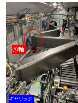
ロボットアーム動作状況 (槽葉検証時)
