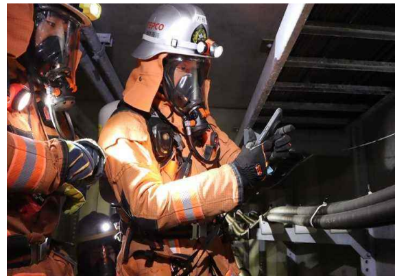
地下トンネル（洞道）内の火災箇所を確認
