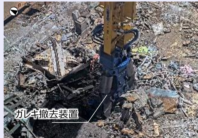
< 1号機オペフロ上でのガレキ撤去作業の様子 (撮影日: 2026年7月16日) >
