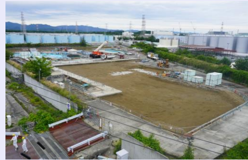
＜D1タンク解体後のEエリアの様子（撮影日：2026年6月15日）＞
