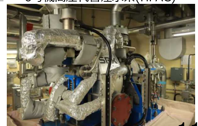
6号機高圧代替注水系(HPAC)
