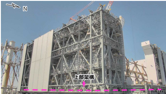
現場状況（南東面） （撮影：2月25日）
