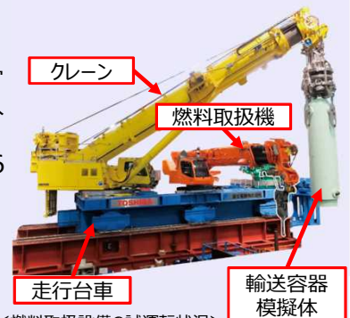
<燃料取扱設備の試運転状況> (クレーン運転状態を確認中)
