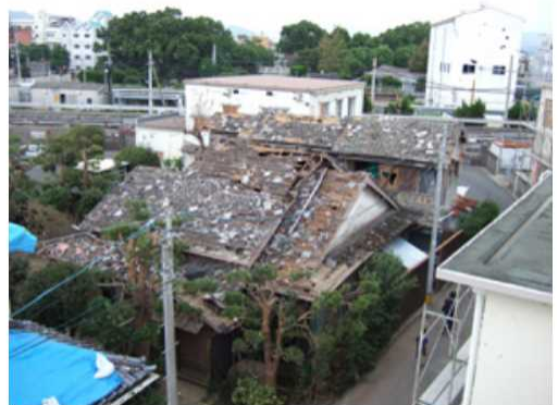
屋根瓦が飛んだ家屋（平成18年9月17日：宮崎県延岡市） 写真提供：気象庁
