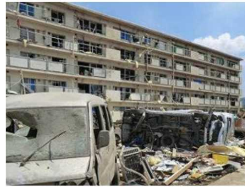
被害を受けた住宅と大破した自動車（平成24年5月6日：茨城県つくば市） 写真提供：気象庁
