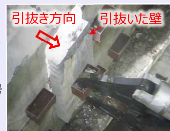
<壁引抜作業の様子>
