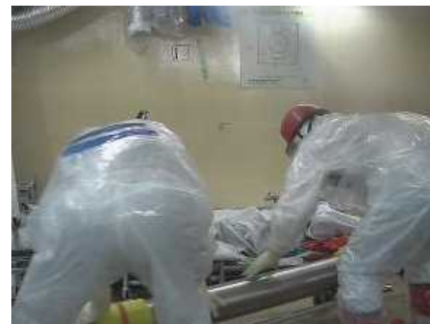
原子炉建屋内 1 階西側通路からテレス コ式装置近傍に運搬 (2024年7月29日)
