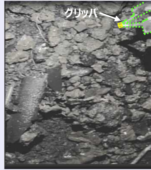
<ペDESTAL底部の状況>
