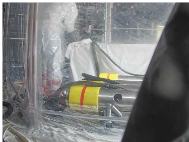
押し込みパイプへケーブル入線作業を実施 (2024年7月28日)
