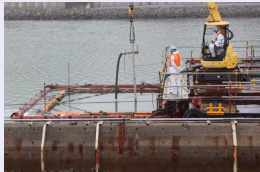
<海底再被覆工事(覆土施工)の様子>
