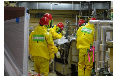
1号炉 除染作業
