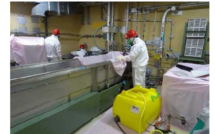
3号炉 除染作業
