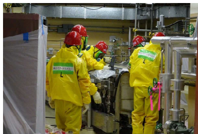
1号炉 除染作業
