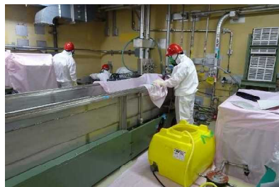
3号炉 除染作業
