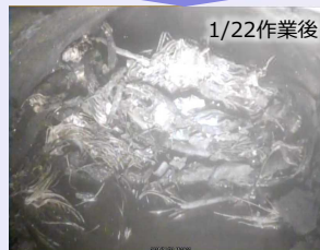
<低圧水による堆積物除去の様子> 2/8
