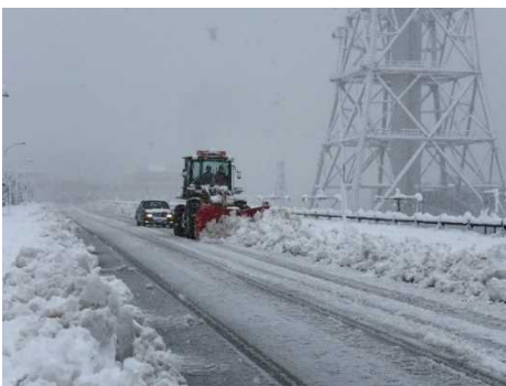
発電所構内での除雪作業
