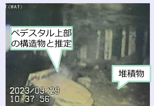
＜ペDESTAL底部の状況＞
