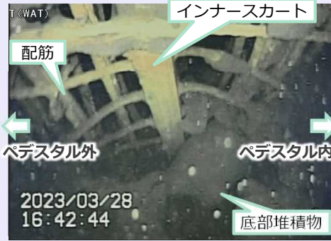
<ペDESTアル開口左側配筋の状況>
